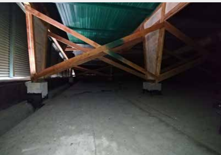
▲ Obr. 10 Nabetonávka horního pasu pro konstrukci dalšího střešního pláště
