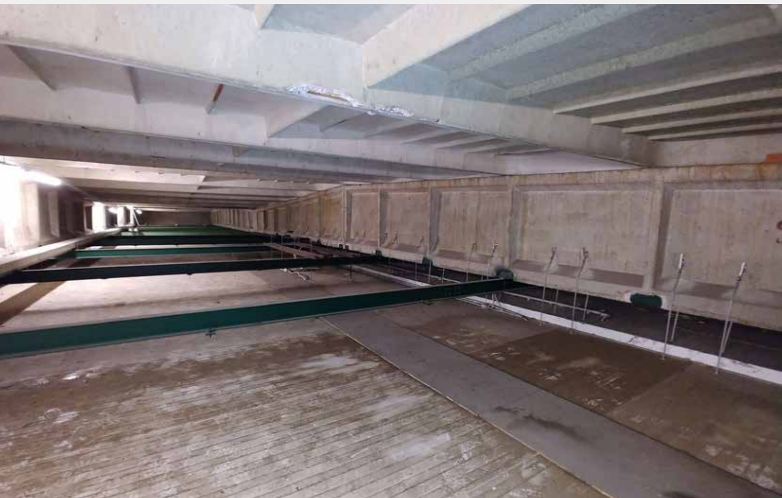
▼ Obr. 11 Kotvení nosných prvků pohledu do vazníku
