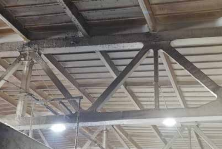
▲ Obr. 8–9 Kotvení ve styčnicích
