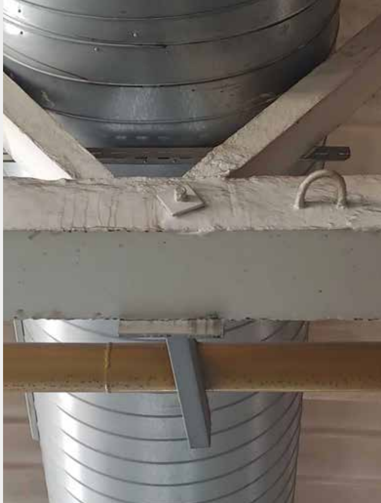
▲ Obr. 5–7 Kotvení technologických zařízení a rozvodů do celé konstrukce vazníku
